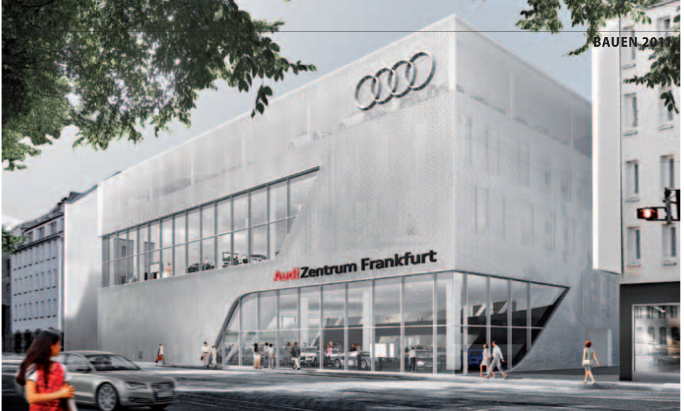
Am 3. November 2011 war Richtfest für ein aktuelles VWI Projekt: In Frankfurt in der Hanauer Landstraße 144 entsteht derzeit eine fünfgeschossige (!) Audi Terminal-Architektur.
